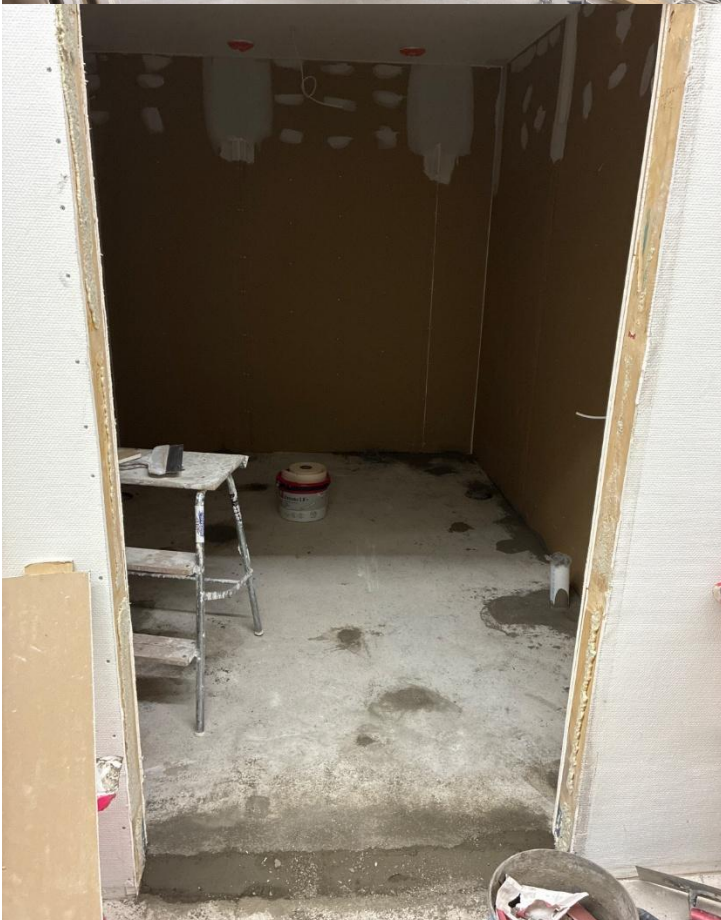
Lohko 4 wc tilat valmiina tasoitus työhön → Block 4 WC areas are ready for skim coating works.
