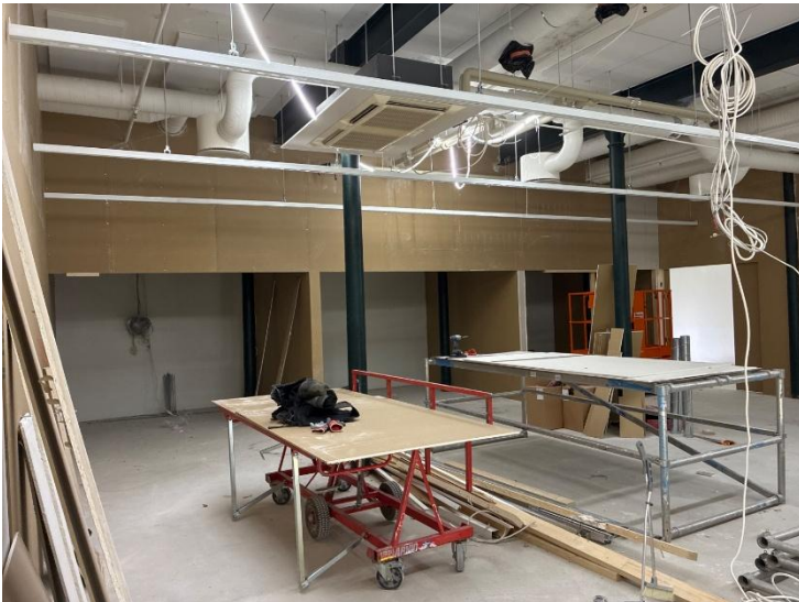
Lohko 4 levytystyöt käynnissä → Block 4 partition wall works ongoing
